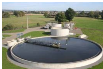
Les Herbiers WWTP
